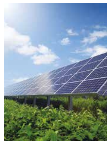
太陽光発電設備
