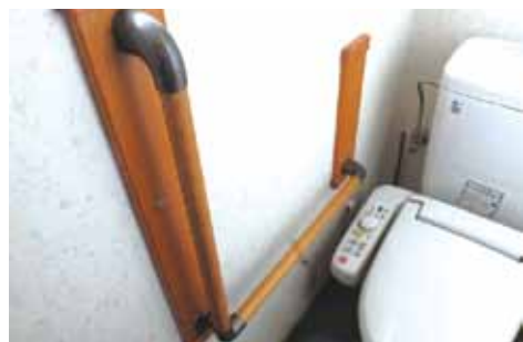
トイレの手すり取り付け例
