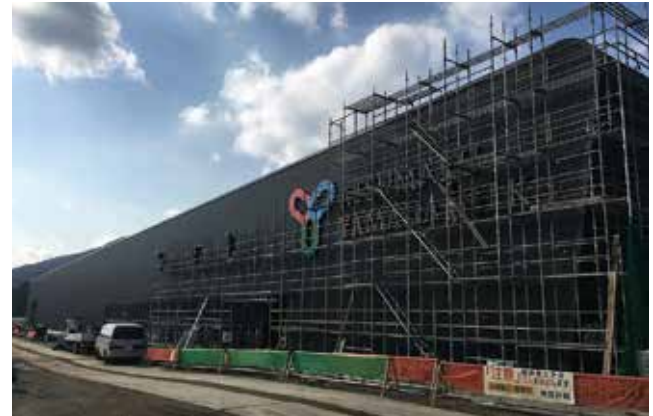
1月11日の足場撤去の様子
