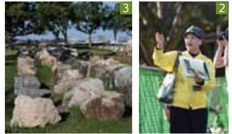
1_複数箇所ですて石垣が損壊(写真は戌亥櫓) 2_修復中の熊本城を案内するボランティアガイド 3_同じ位置に復元するため整理された崩れた石垣
