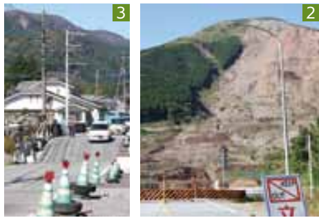
1_倒壊した拜殿(阿蘇神社) 2_崩落した阿蘇大橋と土砂崩れの跡(南阿蘇村) 3_地盤沈下で寸断された道路も現在は通行できる(阿蘇市)
