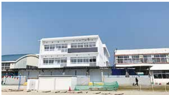
鹿本小学校校舎建築工事の状況
