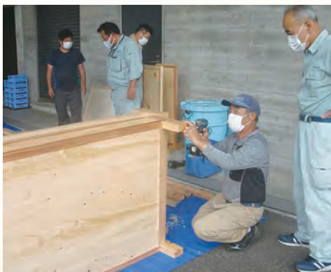
掲示板を製作する鹿北町建築組合の皆さん
